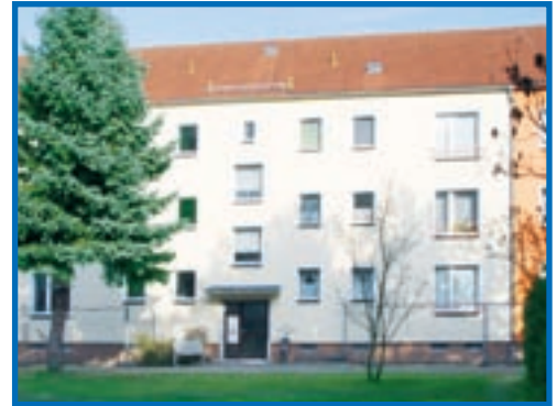
Standort Friedenseck 5 bereits begonnen.
